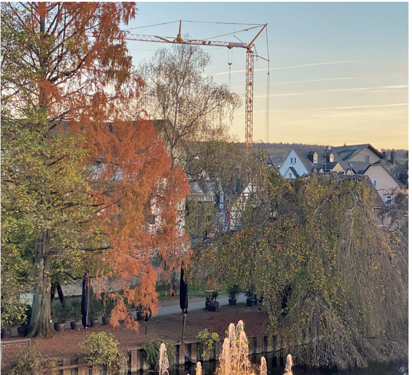
Blick auf die Baustelle in der Altstadt
