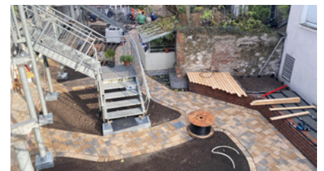
Güllgasse 14: mehr Aufenthaltsqualität auf dem neuen Flachdachinnenhof
